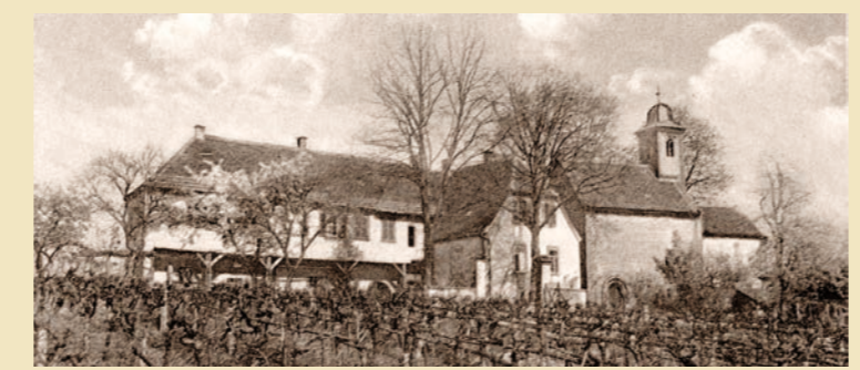
Magdalenenhof mit Nebengebäuden und Nikolauskapelle, von Süden.
