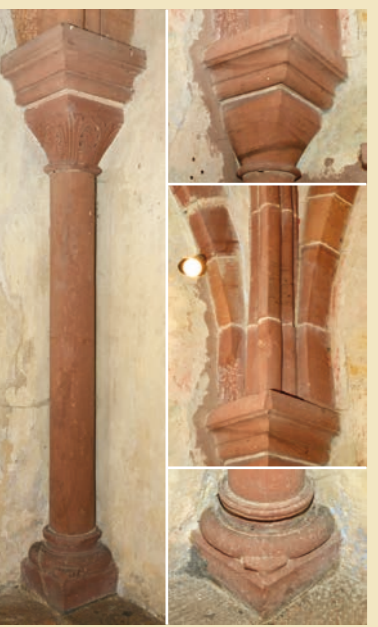
Die Säulenformen in der Kapelle. Links Kapitell mit Palmettenlaubwerk und Diamantbändern; oben Kelchblockkapitell und unten attische Base mit Eckknolle. In der Mitte Ansätze der Gewölberippen im Chor.
